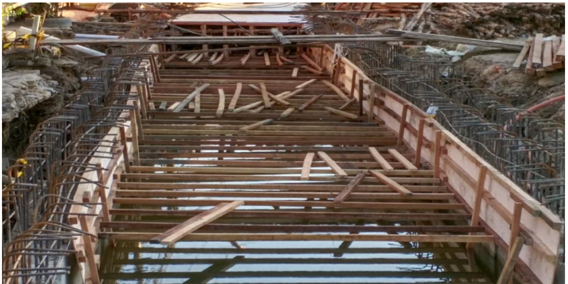
Pemasangan Bekisting di Lokasi Galian
