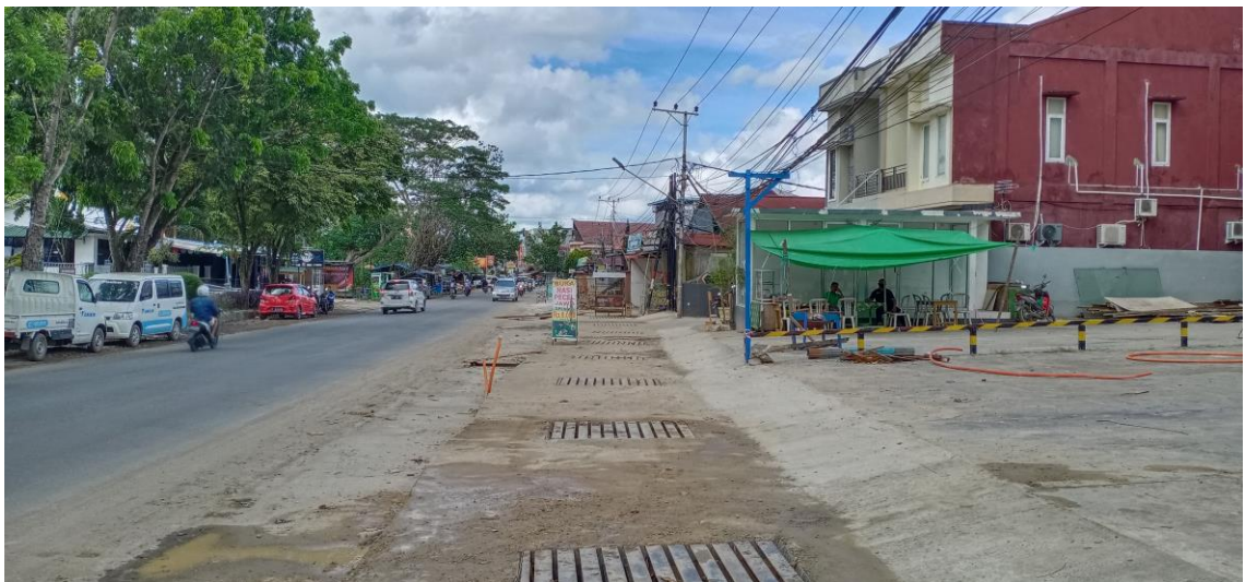
Tampak Drainase Sesudah Diperbaiki
