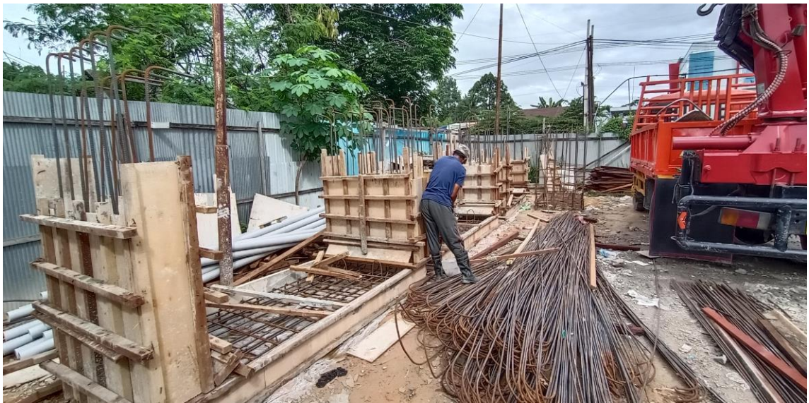
Pemasangan Bekisting Precast
