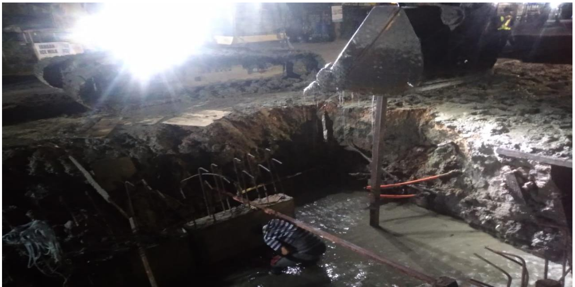
Pekerjaan Pemancangan Kayu Ulin
