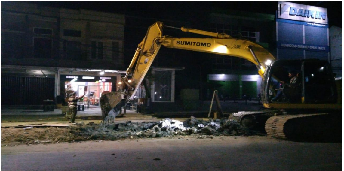
Penggalian Lokasi Pekerjaan Drainase
