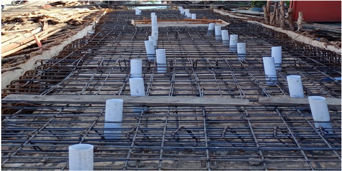
Pembesian dan Pemasangan Pipa Drain
