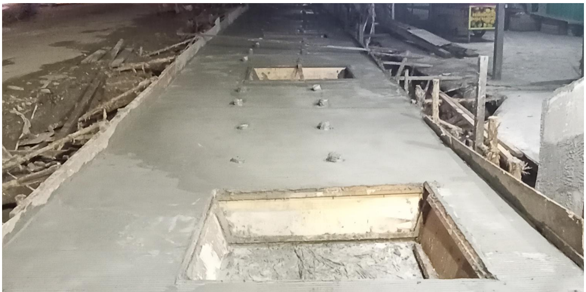
Hasil setelah Pengecoran
