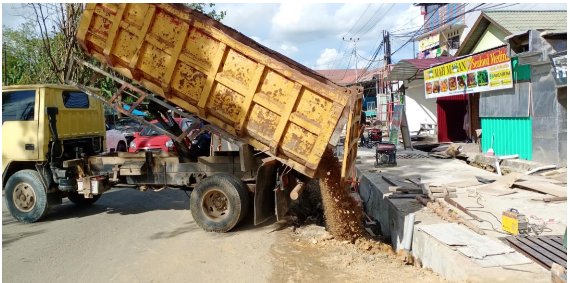
Pengurugan Tanah pada Sisi Warga dan Sisi Jalan
