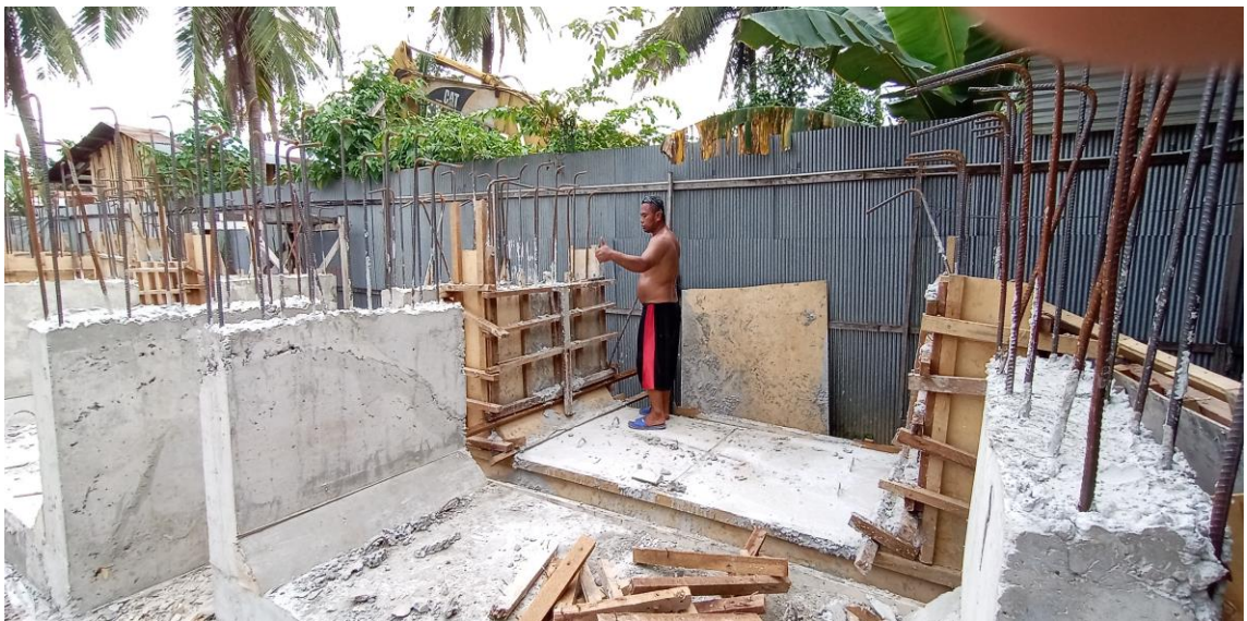
Pembongkaran Bekisting Precast
