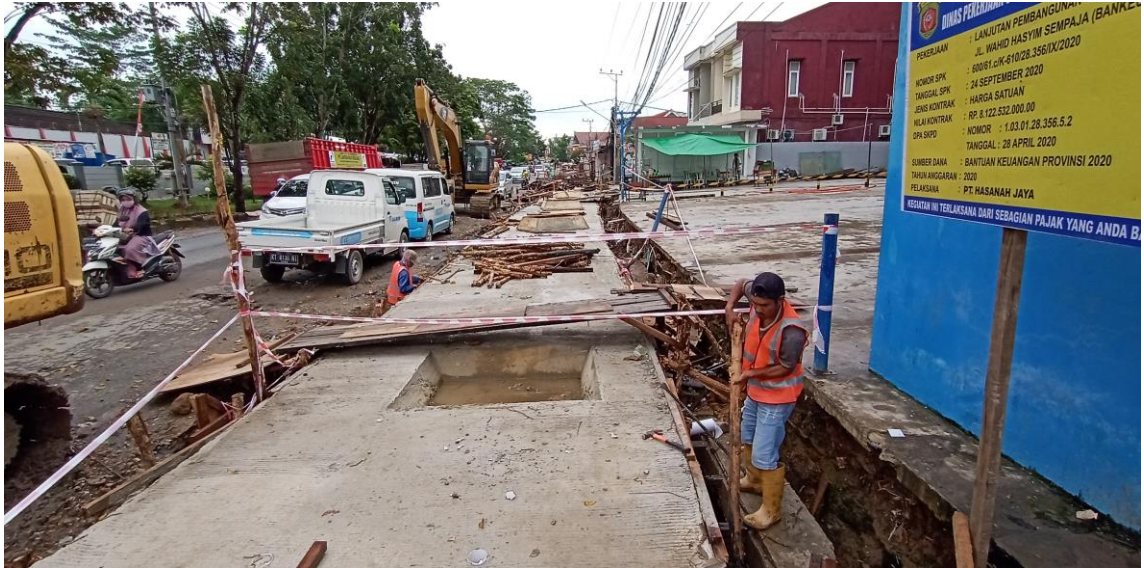
Pembongkaran Bekisting
