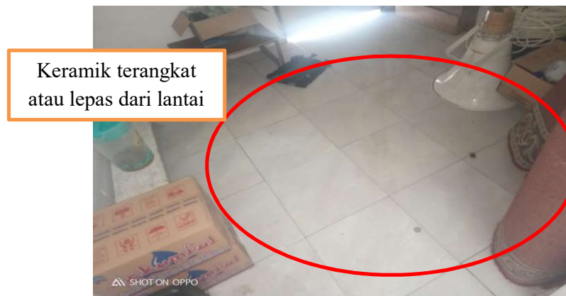
Gambar 4.15. Lantai Masjid Al-Ikhlas
