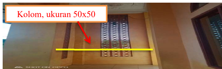
Gambar 4.13. Kondisi Kolom Masjid Al-Ikhlas
