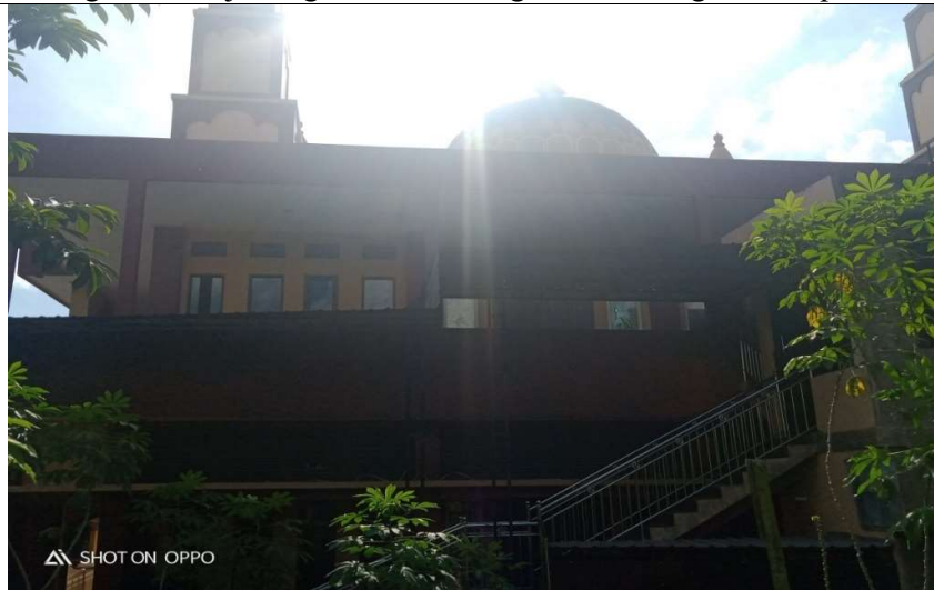
Gambar 4. Tampak arah Timur Kondisi bangunan masjid bagian arah Timur
