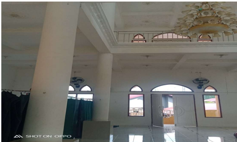
Gambar 17. Kondisi kolom dalam masjid
