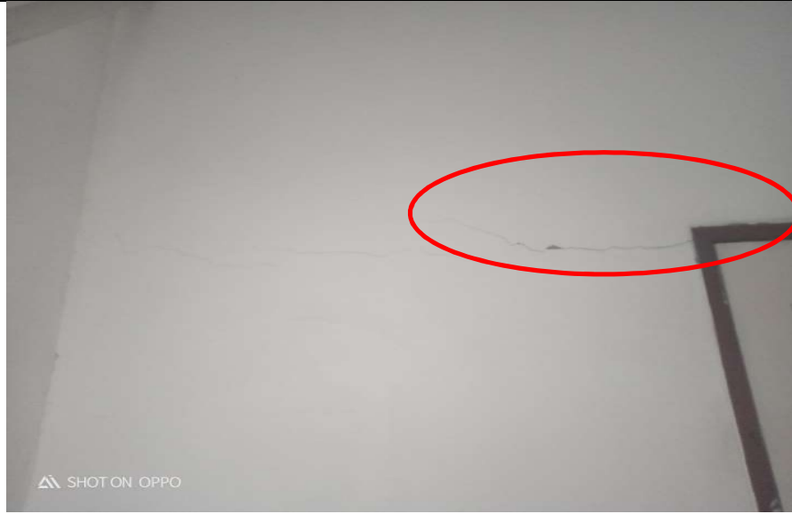
Gambar 34. Dinding bagian gudang masjid Kondisi pada bagian dinding gudang masjid mengalami retak sedang
