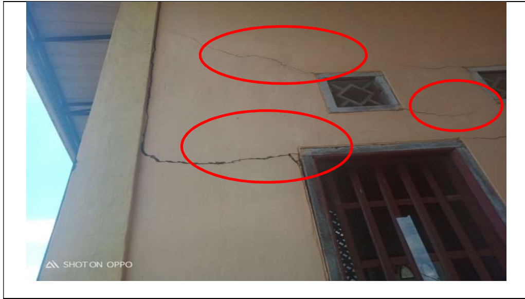
Gambar 28. Kondisi dinding arah Barat
