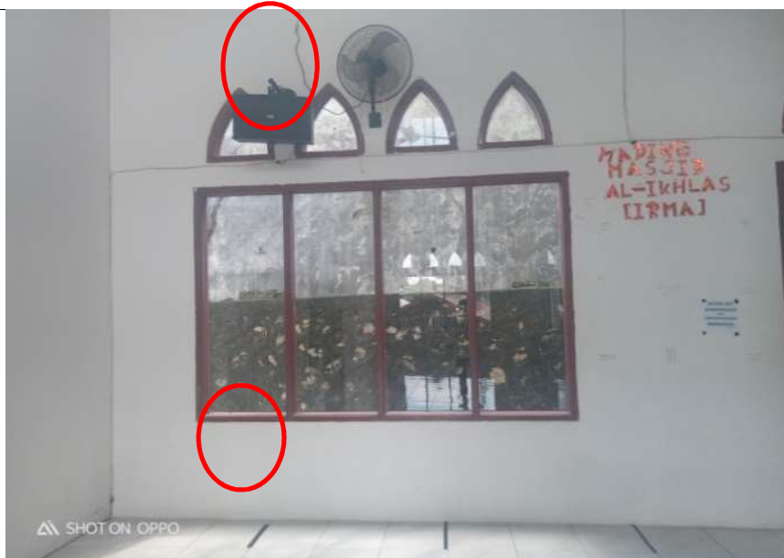
Gambar 34. Dinding bagian gudang masjid Kondisi pada bagian dinding gudang masjid mengalami retak sedang
