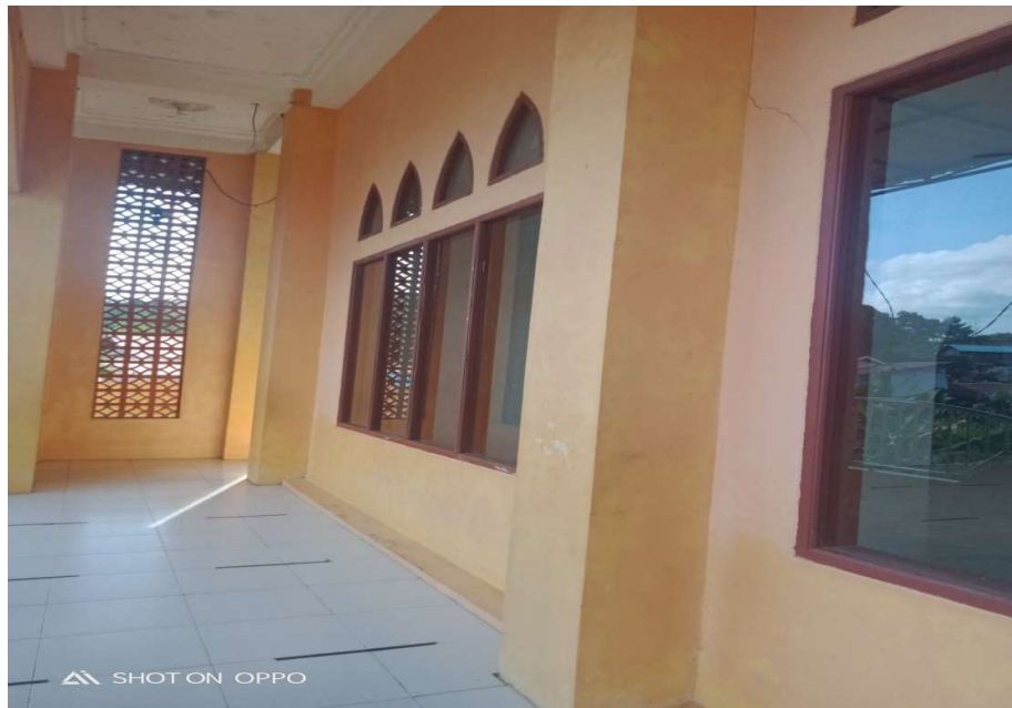
Gambar 16. Kondisi kolom Selatan
