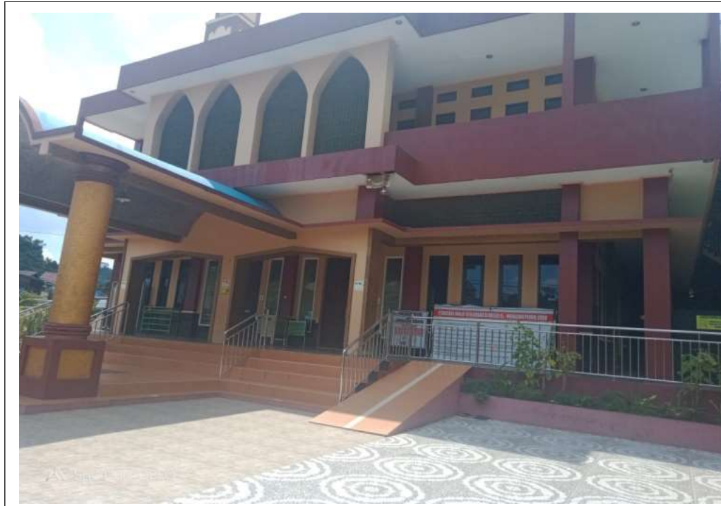
Gambar 3. Tampak depan arah Selatan Bangunan masjid bagian Selatan di gunakan sebagai lahan parkir kendaraan
