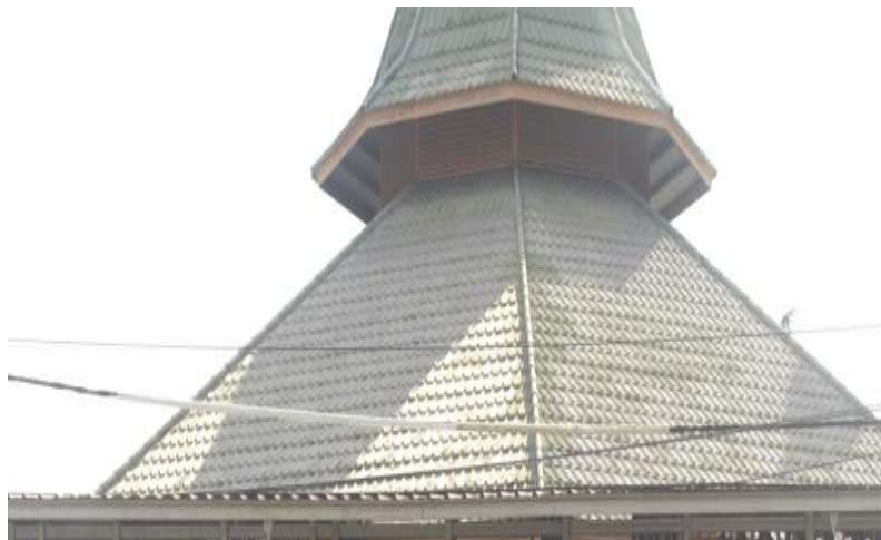
Gambar 5. Tampak atap Kondisi atap masjid dalam keadaan baik
