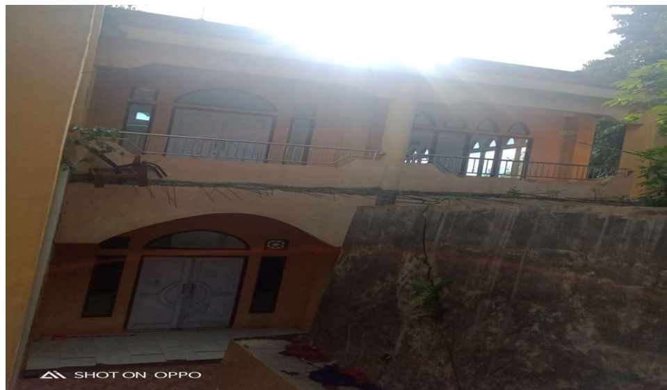
Gambar 3. Tampak Timur Bangunan masjid tampak Timur menghadap rumah warga
