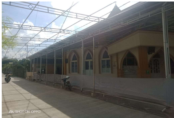
Gambar 3. Tampak Selatan Bangunan masjid tampak Selatan sebagai lahan parkir kendaraan
