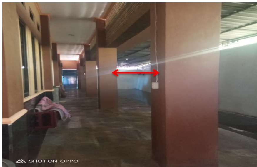
Gambar 24. Penampang kolom masjid
