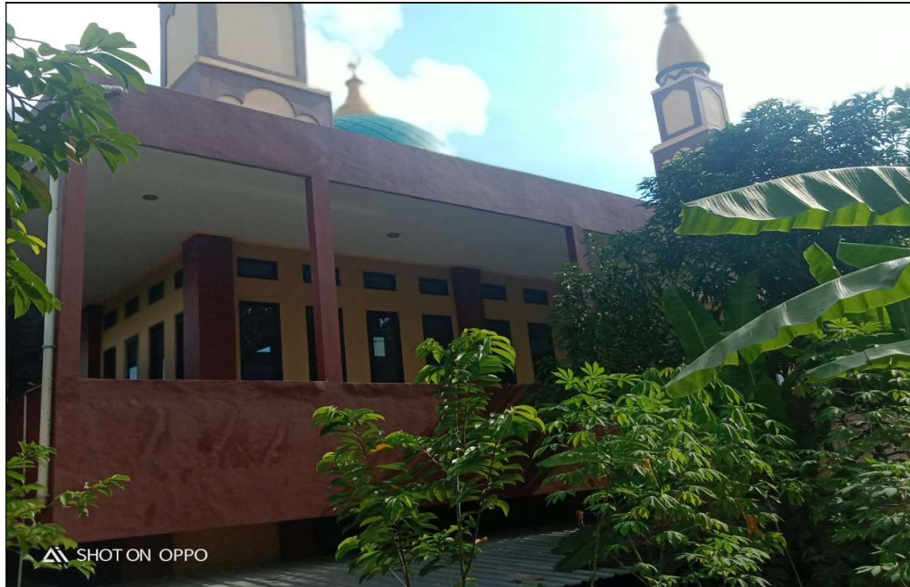
Gambar 5. Tampak arah Utara Kondisi bangunan masjid bagian arah Utara
