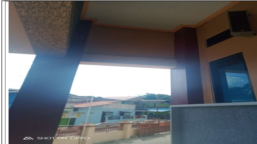
Gambar 17. Penampang balok masjid Kondisi pada bagian balok tidak ada kerusakan. Pada bagian teras masjid ini menggunakan ukuran balok 20 x 35 cm
