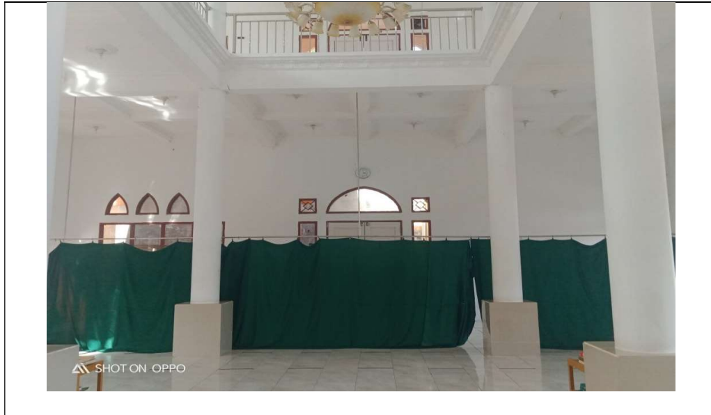
Gambar 18. Kondisi kolom dalam masjid
