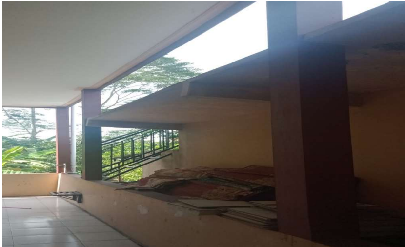
Gambar 19. Penampang kolom masjid
