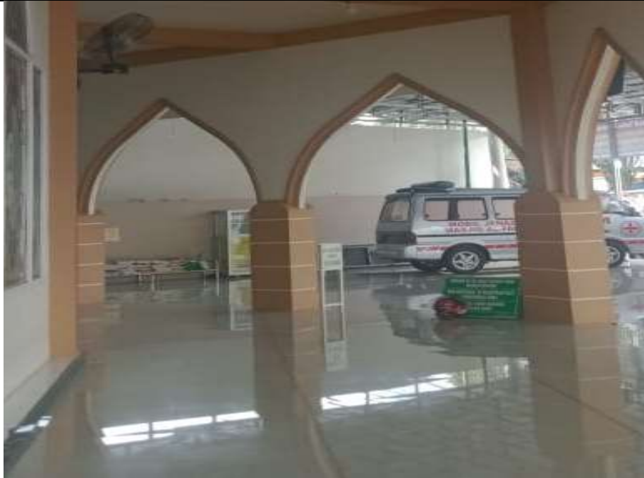
Gambar 16. Kondisi kolom arah Utara
