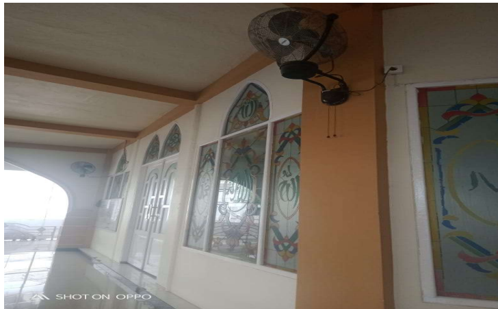
Gambar 11. Kondisi balok arah Selatan
