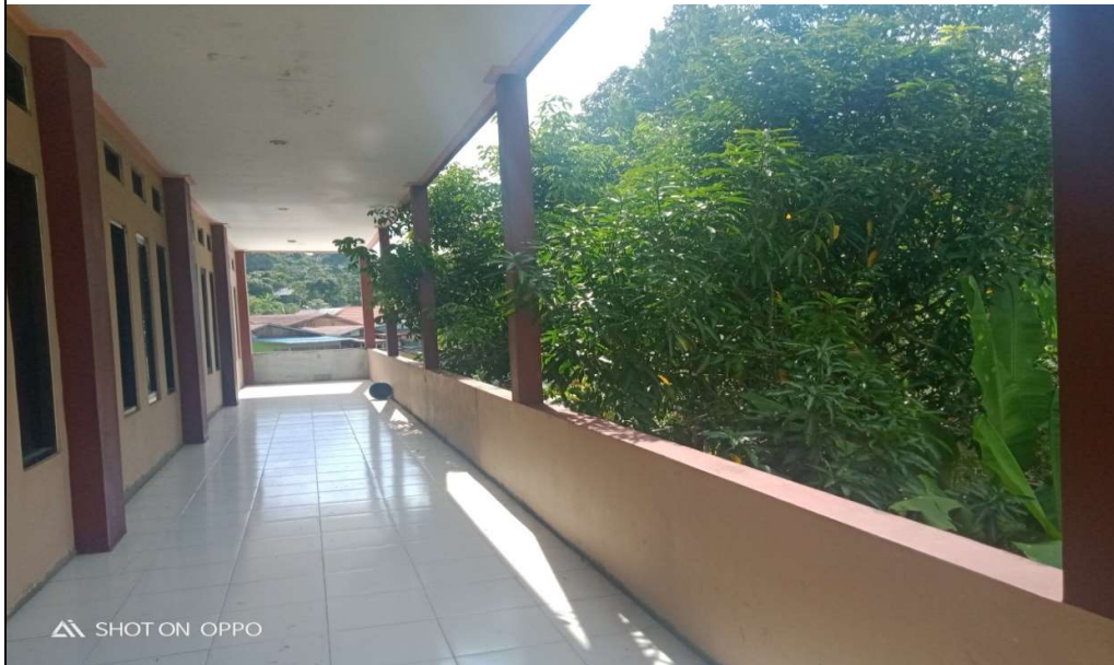
Gambar 20. Penampang kolom masjid
