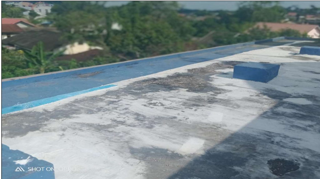
Gambar 7. Tampak dak arah Timur
