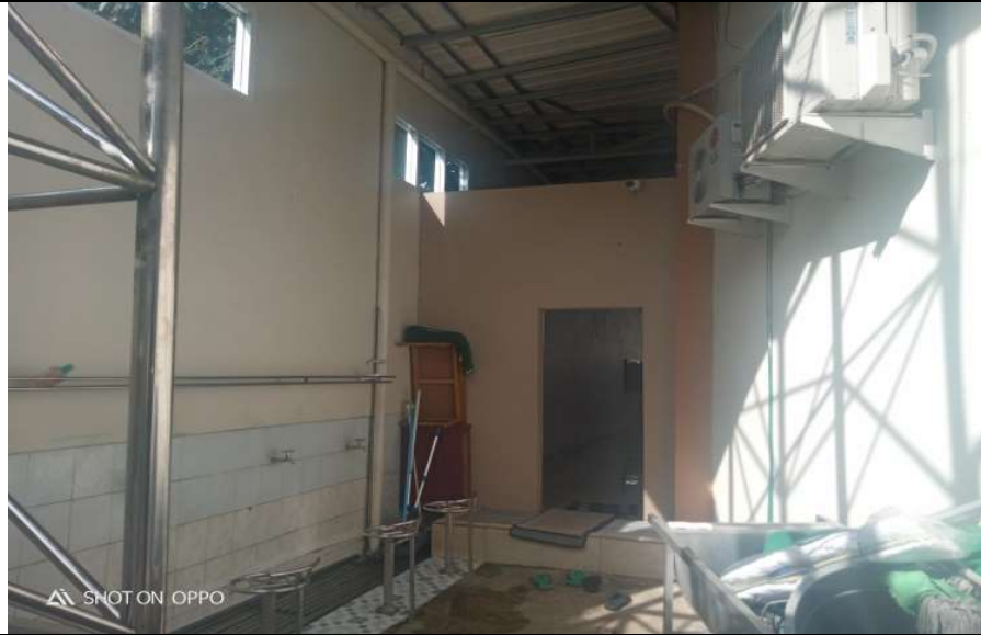
Gambar 8. Kondisi dinding arah Utara Kondisi dinding arah Utara yang tidak memiliki retakan ringan atau sedang
