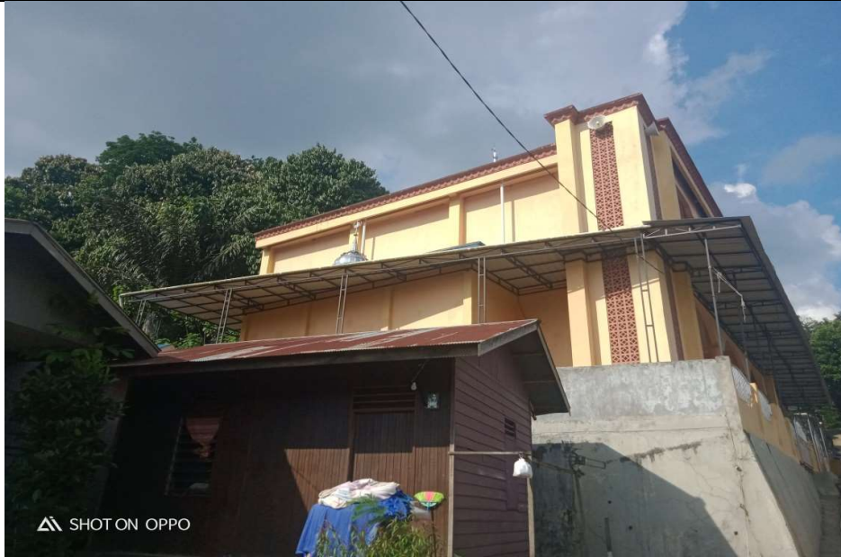
Gambar 4. Tampak Barat Bangunan masjid tampak Barat merupakan bagian belakang bangunan
