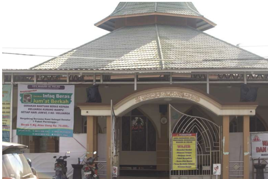
Gambar 2. Tampak Timur Bangunan masjid tampak Timur (menghadap jalan raya)
