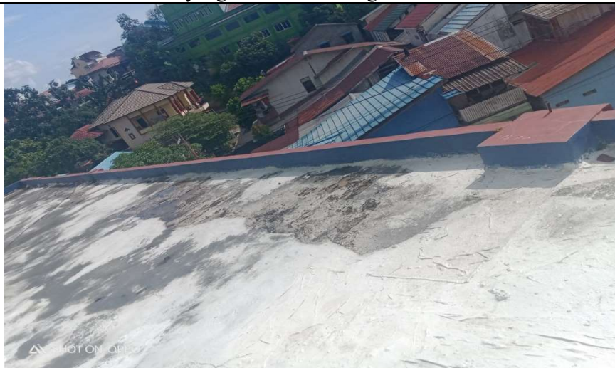
Gambar 8. Tampak dak arah Utara
