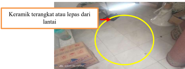
Gambar 5 : Lantai Masjid Al-Ikhlas
