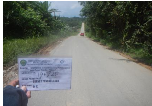
Kondisi Ruas Jalan Semoi Sepaku Petung 1 STA 17+325.
