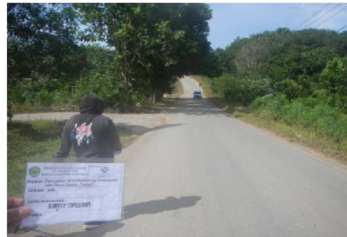
Kondisi Ruas Jalan Semoi Sepaku Petung 1 STA 18+900.
