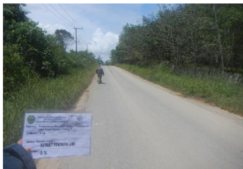
Kondisi Ruas Jalan Semoi Sepaku Petung 1 STA 17+600.
