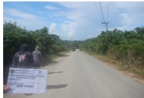
Kondisi Ruas Jalan Semoi Sepaku Petung 1 STA 18+750.
