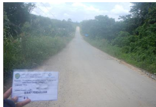
Kondisi Ruas Jalan Semoi Sepaku Petung 1 STA 17+400.
