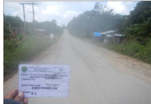
Kondisi Ruas Jalan Semoi Sepaku Petung 1 STA 17+475.
