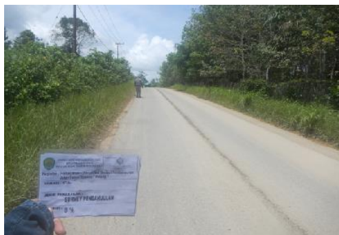
Kondisi Ruas Jalan Semoi Sepaku Petung 1 STA 17+625.
