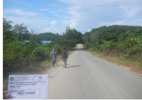
Kondisi Ruas Jalan Semoi Sepaku Petung 1 STA 18+850.
