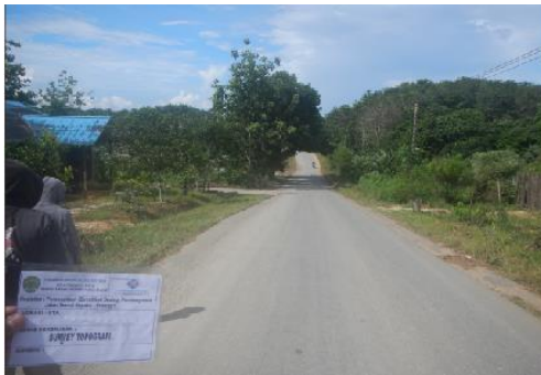
Kondisi Ruas Jalan Semoi Sepaku Petung 1 STA 18+875.
