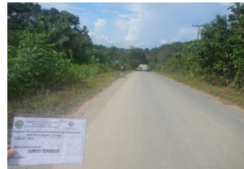
Kondisi Ruas Jalan Semoi Sepaku Petung 1 STA 18+800.
