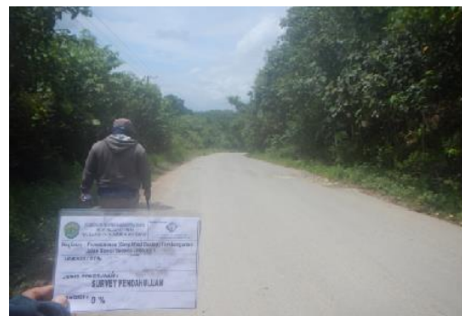
Kondisi Ruas Jalan Semoi Sepaku Petung 1 STA 17+200.
