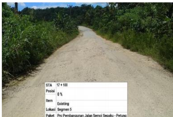
( Kondisi Ruas Jalan Semoi Sepaku STA 17+100 )
