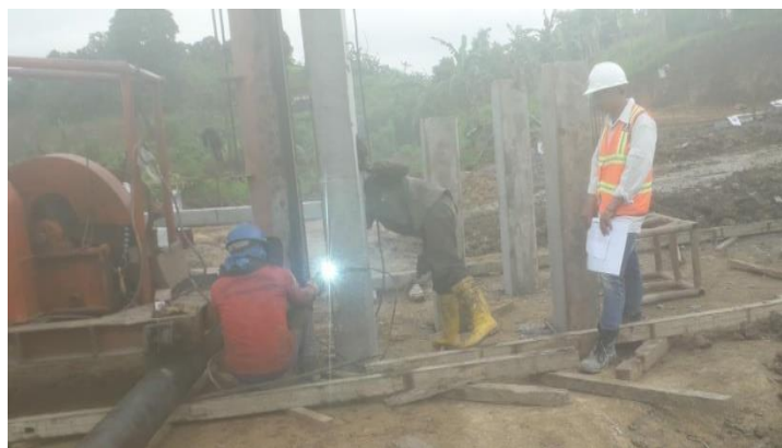
Gambar 3. 5 Penyambungan tiang dengan pengelasan
