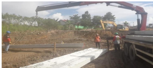
Gambar 3. 3 Lokasi Penyimpanan Tiang Pancang
