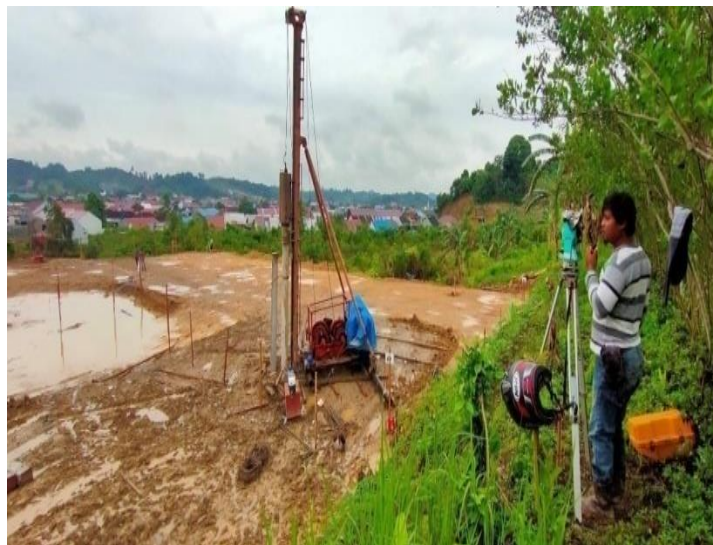
Gambar 3. 1 Pengukuran dan Penentuan Titik pancang
