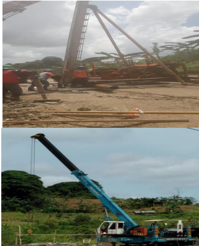
Gambar 3. 2 Alat Pancang drop hammer dan jack in pile
