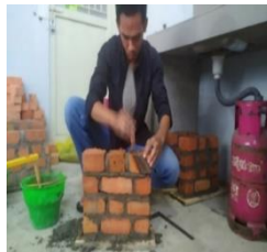
Gambar 3. 32 Pemasangan Dinding Bata
