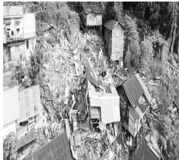
Gambar 2. Kondisi Rumah Korban Longsor Tahun 2017
