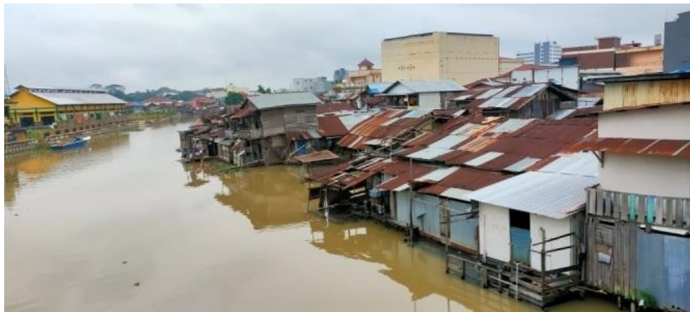
Gambar 2. Sungai Segmen Jembatan Perniagaan
