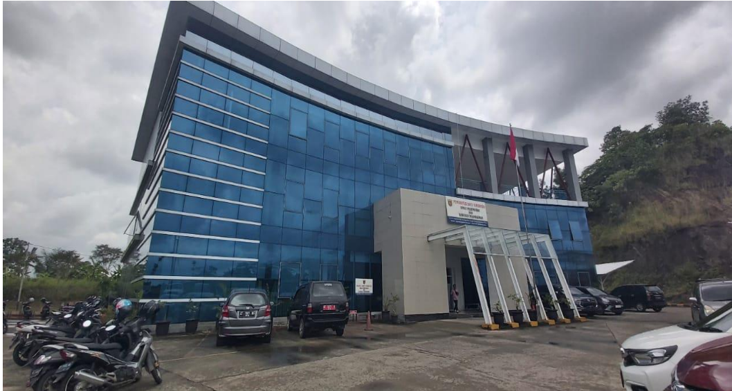
Kondisi Dari Luar Gedung
