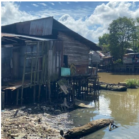
Gambar 3. Kondisi rumah warga
