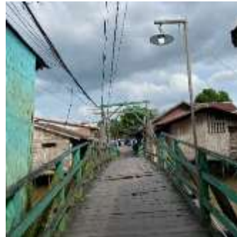
Gambar jembatan penghubung RT.32 dan RT.33
