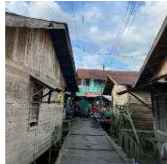
Gambar kondisi jalanan kayu di bantaran sungai
