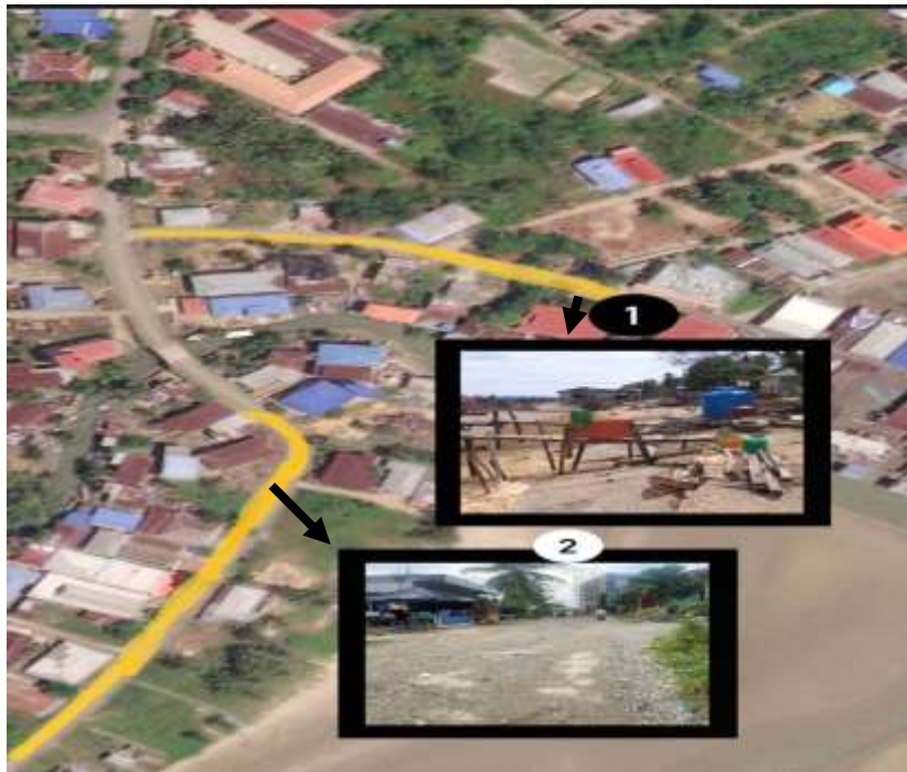
Gambar 1.1 Lokasi Kerusakan Akibat Air Laut Pasang Di Pesisir Pantai. (Sumber: Google Maps , 2023)
