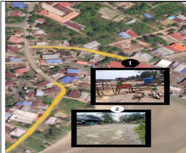
Lokasi Kerusakan Akibat Air Laut Pasang Di Pesisir Pantai.
