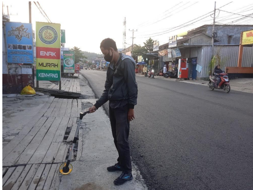
Pengukuran pelebaran Bahu (Jalan Pangeran Suryatana)
