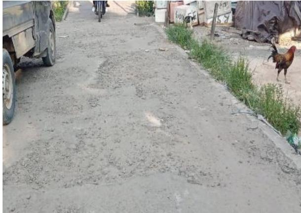
**Gambar 1.3** Perkerasan Mengalami Korosi Akibat Genangan Air Laut
