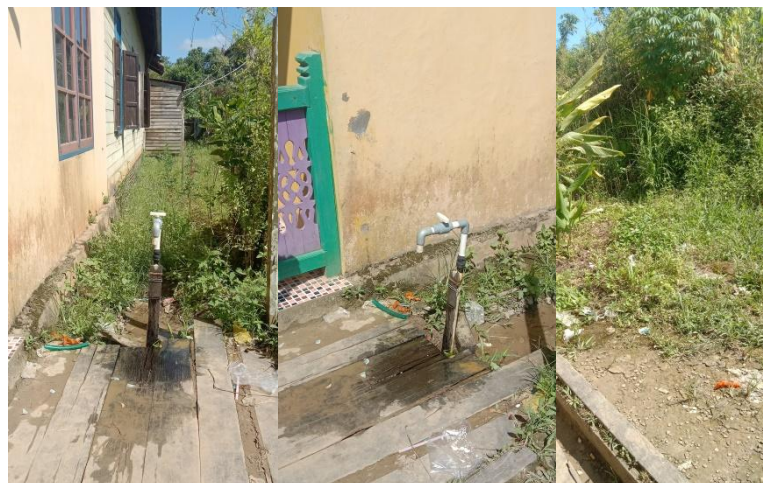
Gambar 5.2 Lokasi Sumur Bor 1
