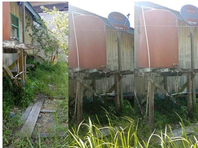
Gambar 5.3 Lokasi Sumur Bor 2
