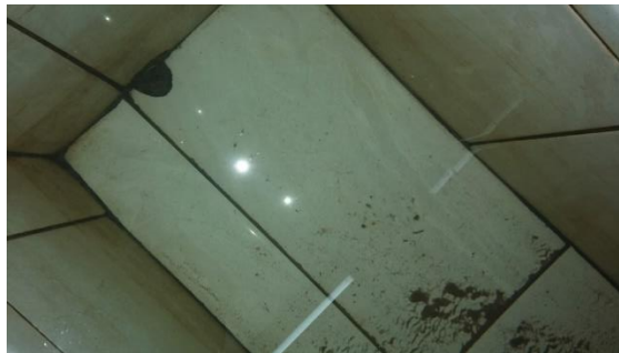
Gambar 4.1 Penampungan Air SDN 004
