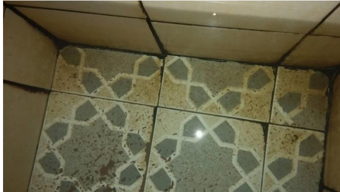
Gambar 4.4 Penampungan Air SDN 011
