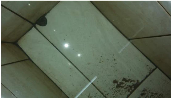
Gambar 4.1 Penampungan Air SDN 004
