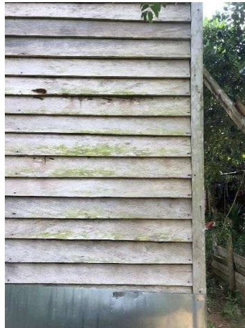
Gambar 3. 2 Sebelum Alat Dipasang di Lokasi Sarang Walet
