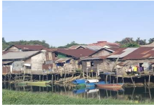
Gambar 8. Rumah Rumah Yang Ada Di Bantaran Terlihat Dari Belakang Rumah
