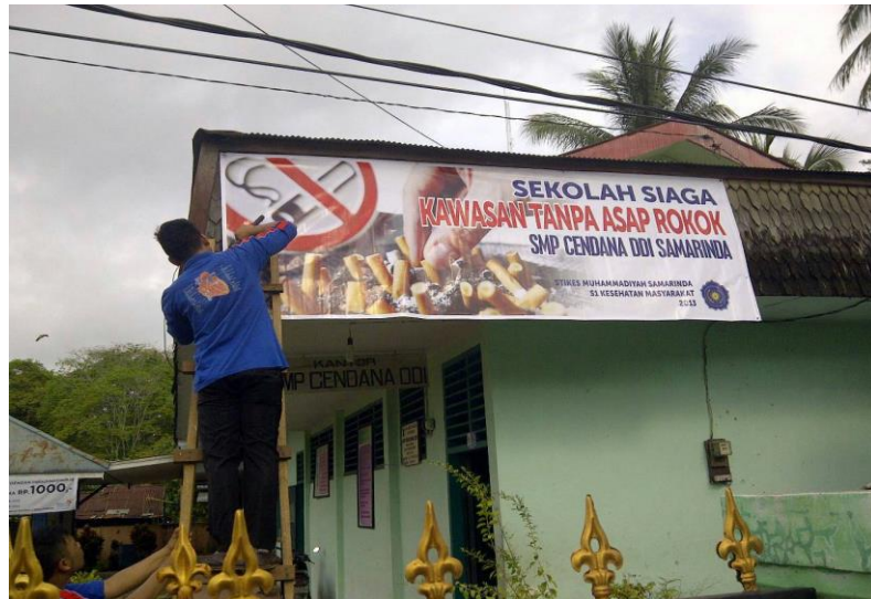
Gambar 13. Pemasangan media KTR di sekolah
