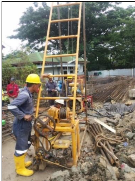
Gambar 2.3 Pengujian N-SPT
