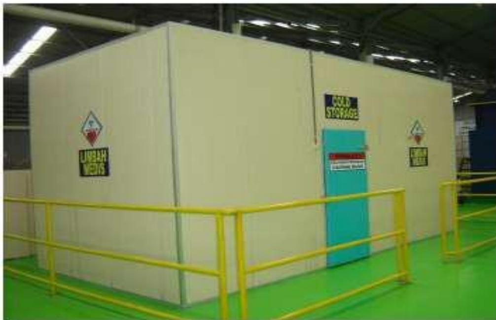
Gambar 2.3 Refrigerator (Lemari ES) Tempat Limbah B3 Disimpan
