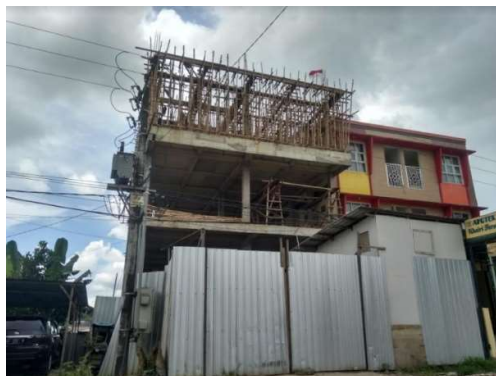
Gambar 1.1 Kayu Galam sebagai Perancah dalam Konstruksi
